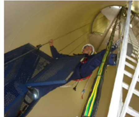
Attraper l'échelle d'une main et placer l'autre pied sur l'échelle.
